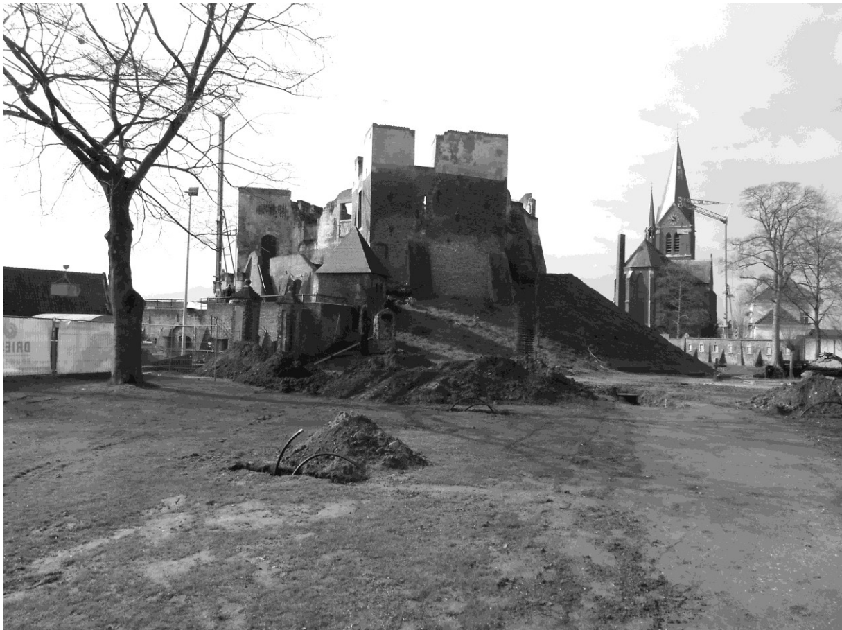
Kasteel de Keverberg te Kessel vanaf de kasteeltuin. Achter de boom is de Neerhof. In de grote toren wordt de liftschacht aangelegd
